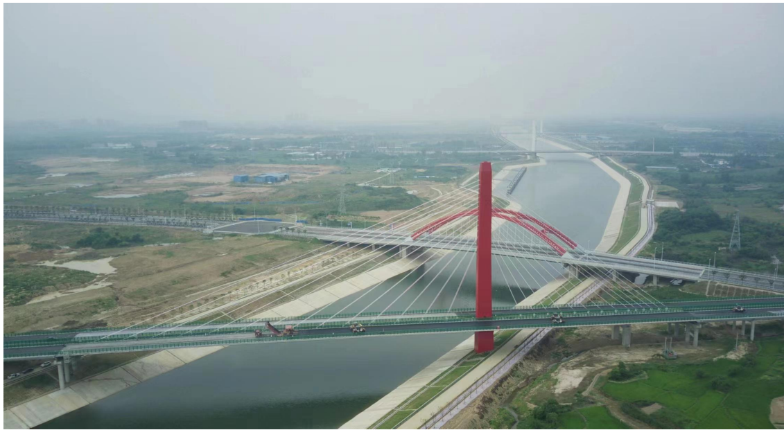
罗埠河大桥航拍图
