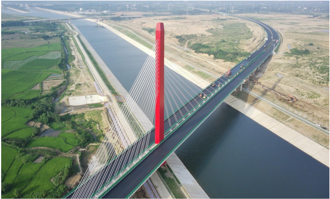
施工现场有序进行
