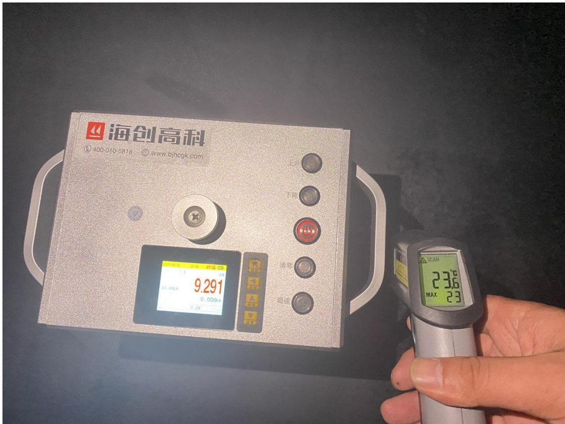
钢桥面层间连接强度检测
